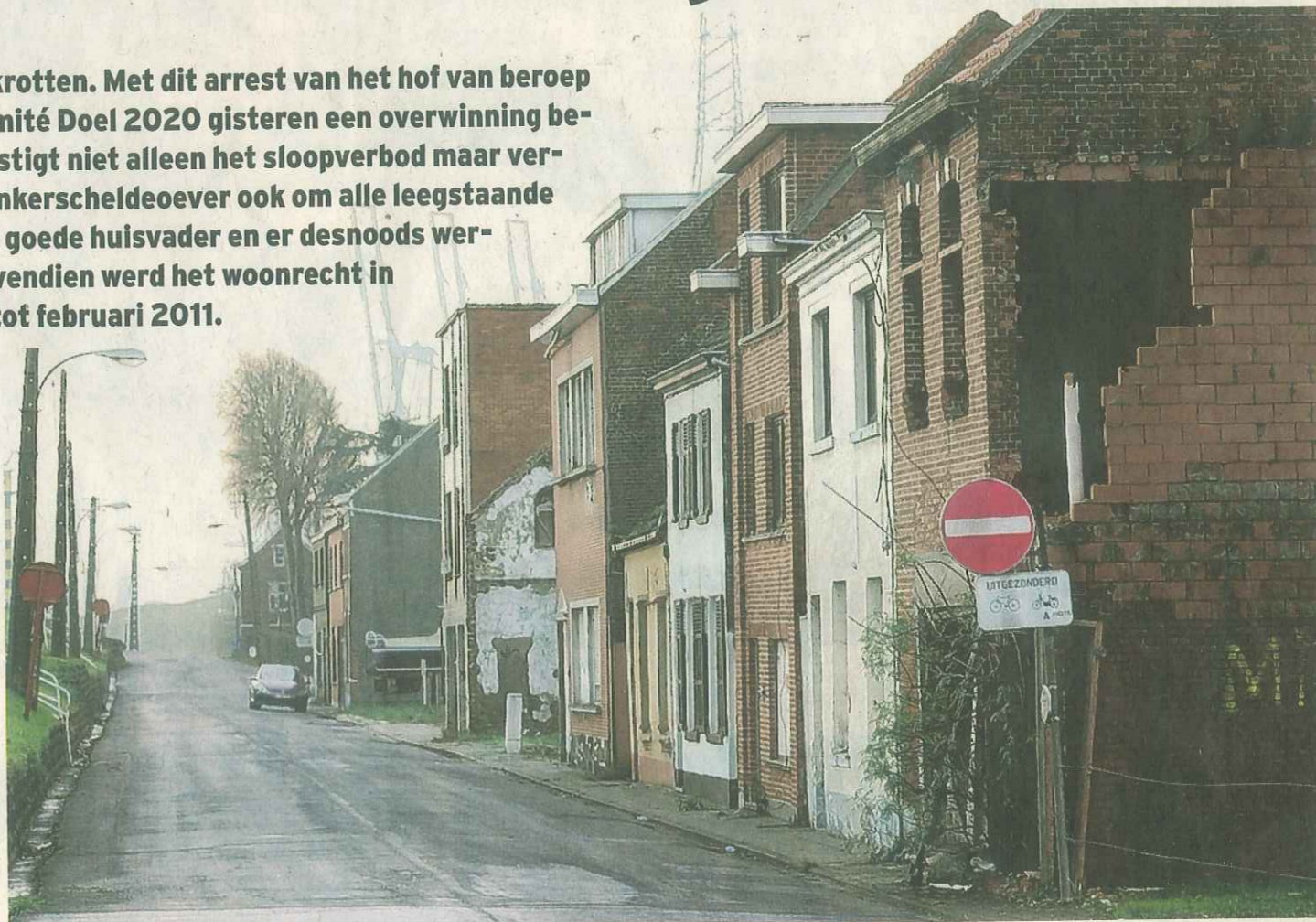
In Doel staan momenteel heel wat leegstaande huizen te verkrotten. Foto's PKM
